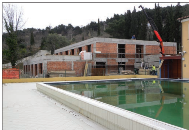
Gradnja nastanitvenega dela Doma paraplegikov v Pacugu. Foto: arhiv ZPS
