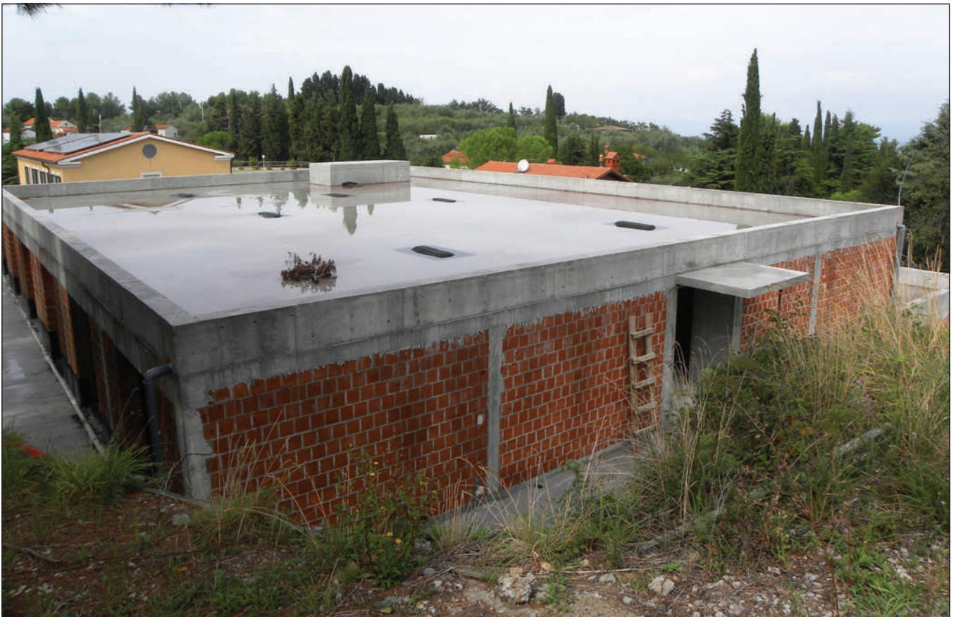
Gradnja bivalnega dela Doma paraplegikov v Pacugu, 2015. Foto: arhiv ZPS
